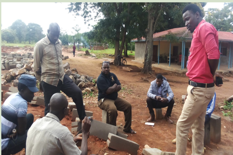
Pichani: Injinia wa Ujenzi Halmashauri ya Wilaya ya Nsimbo Bw. Golden Katoto (Aiyessimama Kulia) akiwasikiliza baadhi ya Vibarua na Wafanyakazi wanaofanya kazi ya Ujenzi na Ukarabati katika Kituo cha Afya Katumba alipofanya ukaguzi Kituoni hapo Machi 8, 2019.
